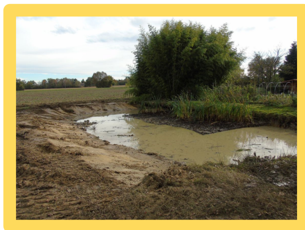
Curage en cours d'une mare avec adoucissement des angles et retalutage d'une partie des berges en pente douce sur la commune de Villars. Source : SRDCBS
