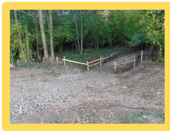
Abreuvoir et passage à gué avec mise en défens sur le Bief de Valeins à Saint Etienne sur Chalaronne. Source : SRDCBS
